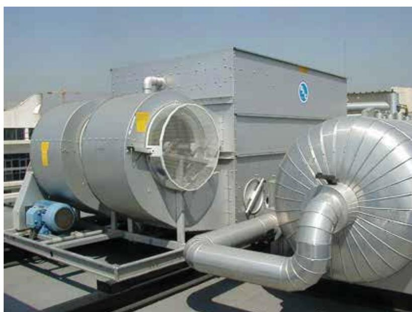
Figura 3: Condensador evaporativo
